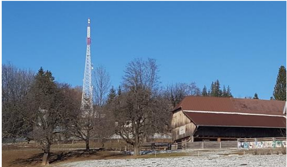
Idyllisch gelegen: DVB-T2-Sendeanlage Köflach/Gössnitzberg, Stmk.
